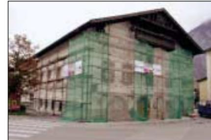
Die Außenarbeiten werden mit der Fassadenrenovierung, dem Austausch der Fenster und der Sanierung der Balkone noch im Herbst abgeschlossen.
