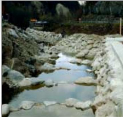
Fischaufstiegshilfe besteht aus zwanzig höhenversetzten Becken, die mit Bachsteinen naturnah errichtet wurden. Sollte in Zukunft das Kraftwerk Melach Unterstufe errichtet werden, so plant die Gemeinde Kematen für die Fischdurchgängigkeit im Bereich der Geschiebesperre und der Melachmündung in den Inn ebenfalls Maßnahmen zu setzen, um eine Fischwanderung in den Oberlauf zu ermöglichen. Dadurch wäre eine zusätzliche Verbesserung der Gewässerökologie in diesem Flussabschnitt gegeben.
